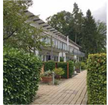
Reiheneinfamilienhäuser am Wald- rand, Stationsstrasse 49g bis 49m
