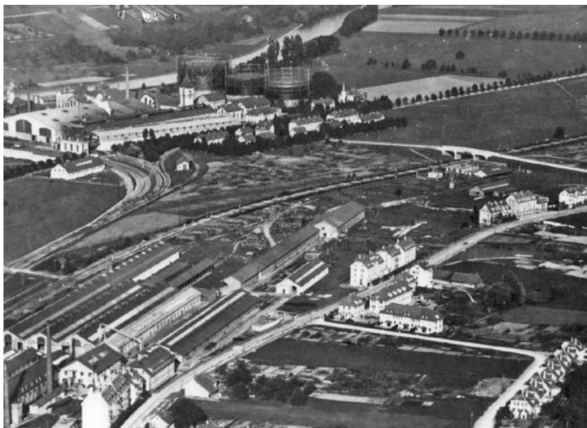
Schlierens Ostteil 1920 vom Zentrum her gesehen: An Zürcher- und Schulstrasse sowie östlich der Bäckerstrasse ist die Überbauung noch sehr locker. Gut zu erkennen am unteren Bildrand auf der rechten Seite sind die heute noch stehenden «7 Hüslis» an der Schulstrasse
