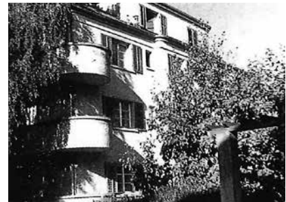
Das Haus Sonnenhofstrasse 3 in einer Aufnahme von 1964: der behäbige Bau mit den ausschwingenden Balkonen entstand 1933
