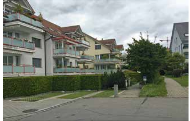
Mehrfamilienhäuser Hofackerstrasse 7 und 9, rechts im Bild angeschnitten des Haus Mühleackerstrasse 9
