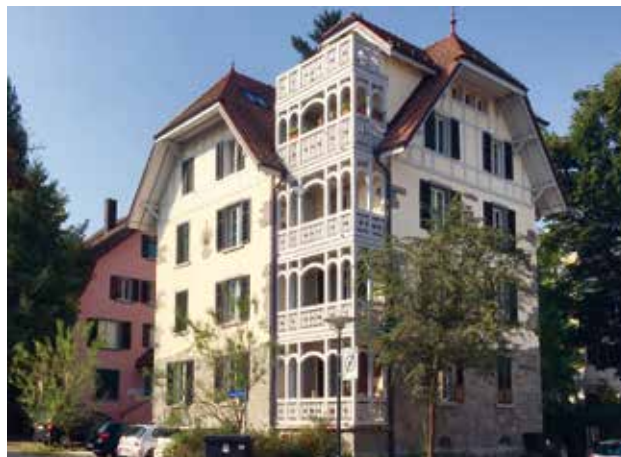
Zu 6.3.1: Gebäude Schulstrasse 8 (Baujahr 1908) und Brunnenackersteig 2 (Baujahr 1925)
