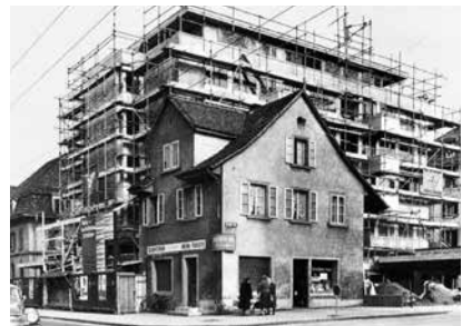
Aufnahme aus dem Jahre 1962 kurz vor dem Abbruch der zweiten Haushälfte
