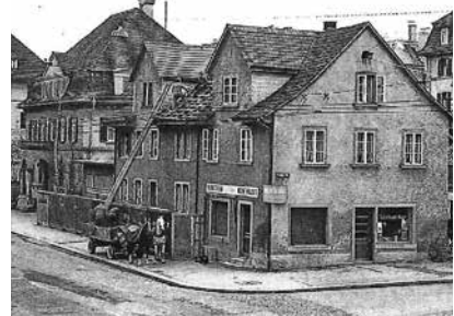
1961: Der Abbruch für die erste Haushälfte beginnt
