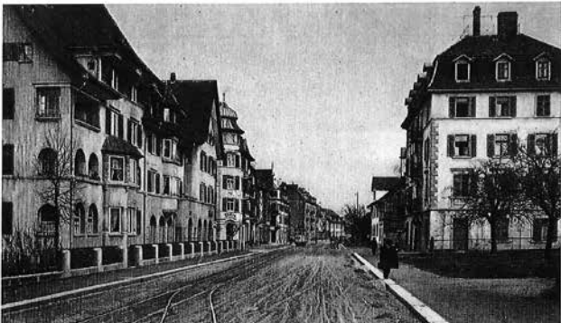
Die Zürcherstrasse (noch ohne Belag) bei der Grabenstrasse um 1912: links das alte Gemeindehaus und rechts das Haus Tentardini mit dem jetzt „Curiosum“ genannten Restaurant
