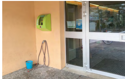
04 Familiengärten Betschenrohr WC-Anlage
