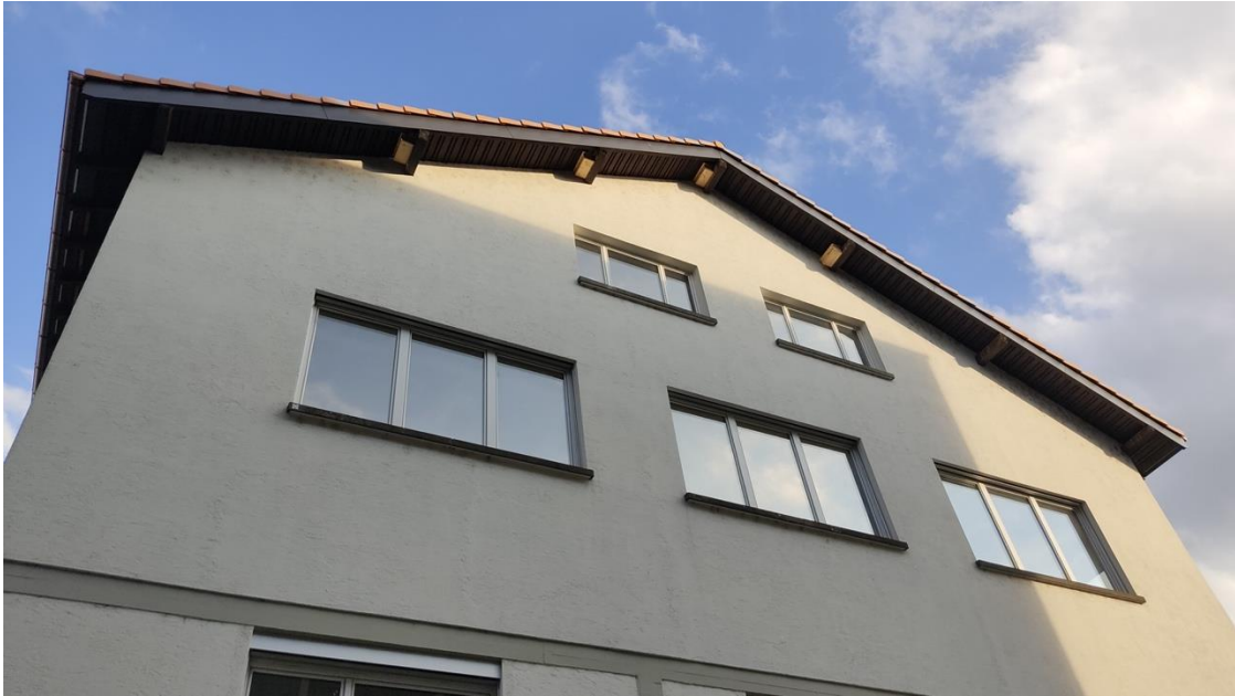
Abb.2: Neu installierte Mauerseglernistkästen an der Zürcherstrasse 137.
