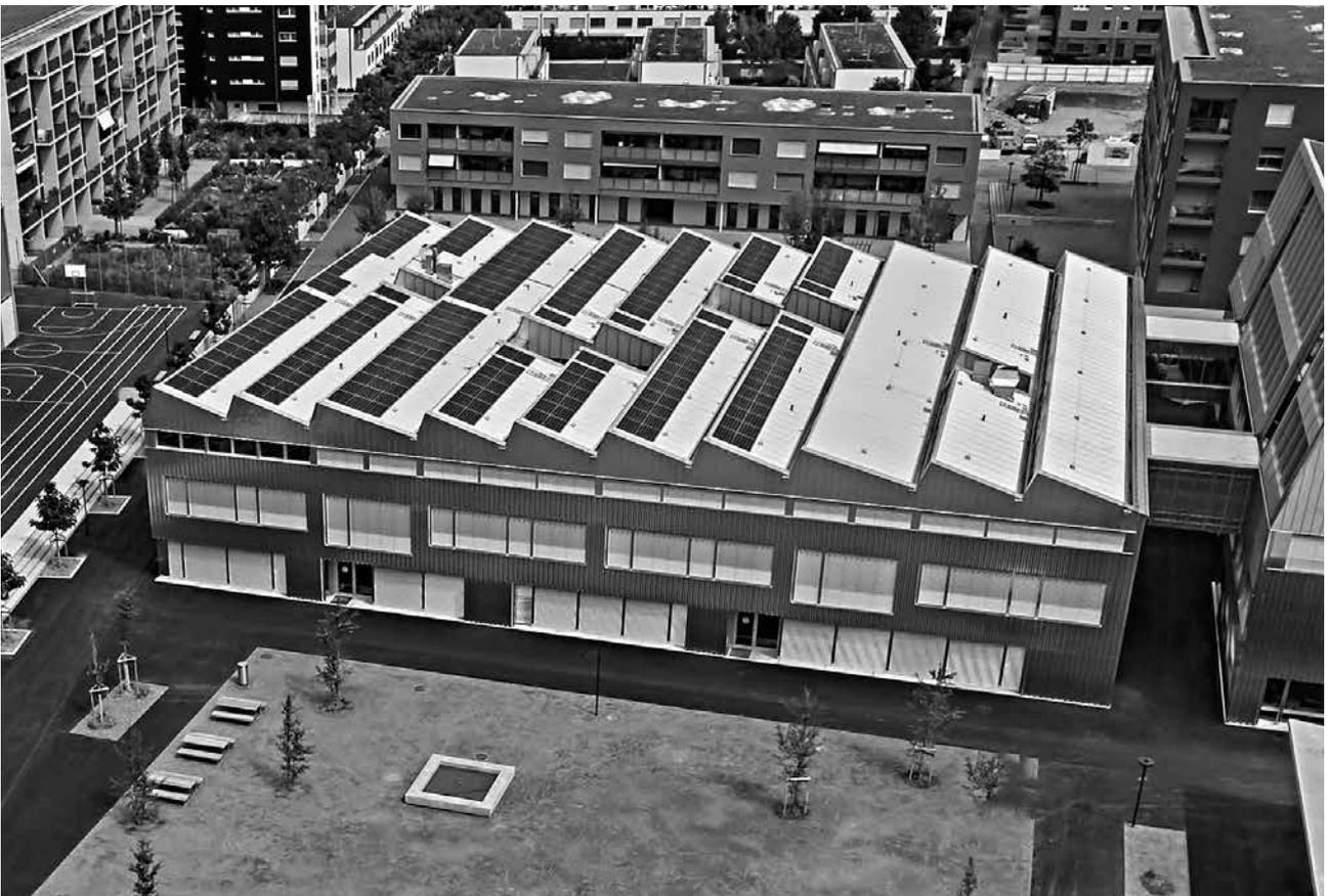
*Die Photovoltaikanlage liefert mit zirka 500 Panels auf 8'000 m<sup>2</sup> rund 135'000 kwh pro Jahr.*
