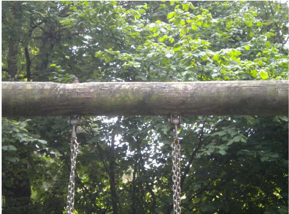
Befestigung der Ketten am Querbalken: Überprüfung Zustand des Holzes und Beschlägen
