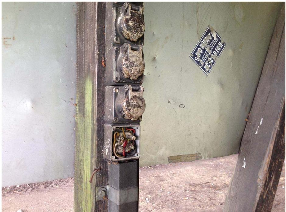
Pavillon: defekte Elektro-Installation
