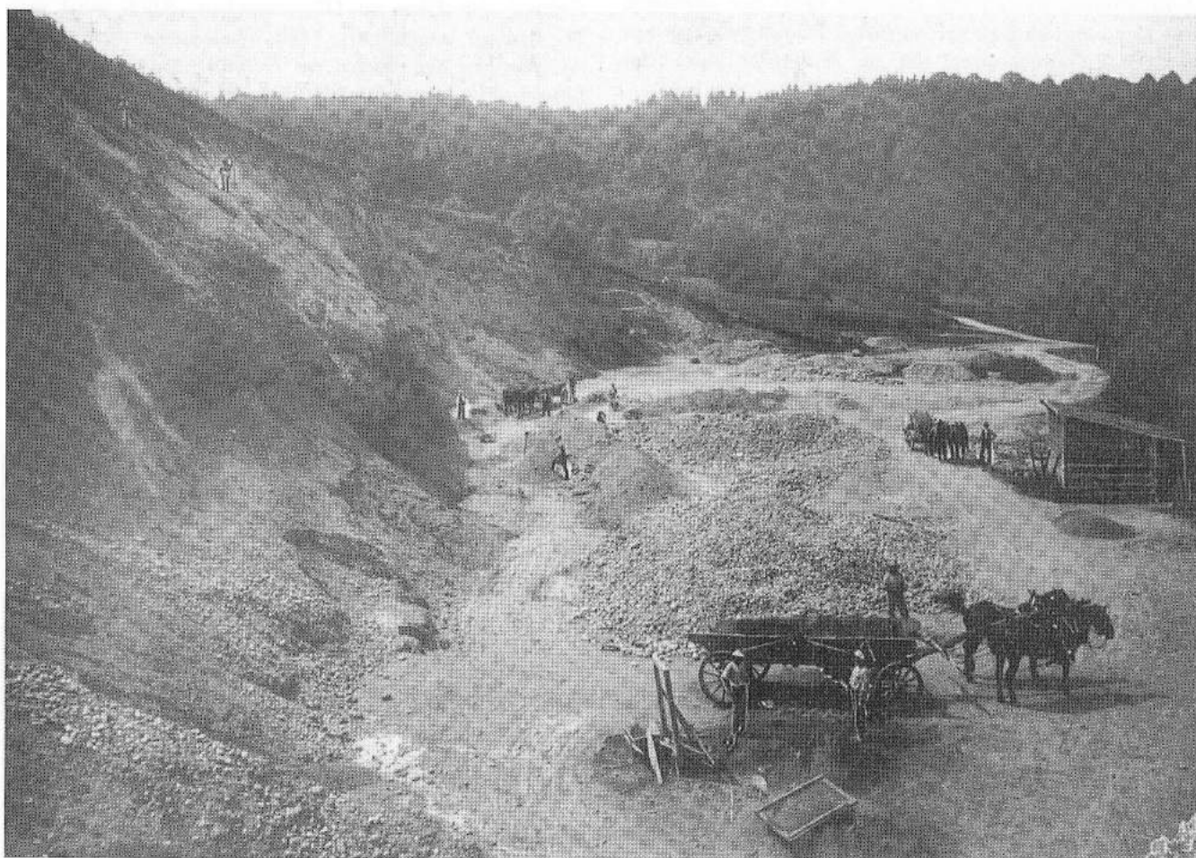
Kiesgrube Wetter ca. anno 1914 am alten Zürichweg. Im Hintergrund die Uitikonstrasse. Das Kies wurde von Hand aufgearbeitet und mit Zweispänner-Bennenwagen zu den Baustellen geführt.
