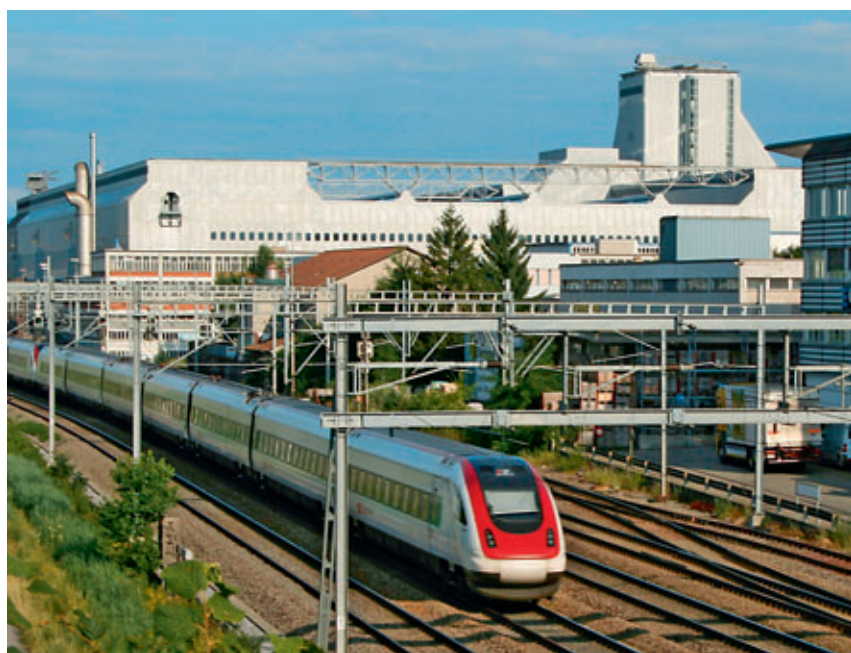
Abb. 1 Rund 70 % der Energie zum Heizen und Kühlen des Postzentrums Mülligen stammen aus regenerativen Quellen. (Quelle: Die Post)
