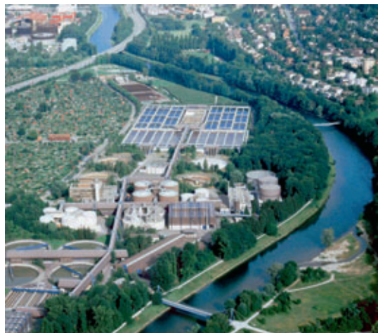
Abb. 2 Zur Versorgung des riesigen Energieverbundes wird erst ein Teil des gereinigten Abwassers der ARA Werdhölzli nach Schlieren gepumpt. (Quelle: ERZ)
