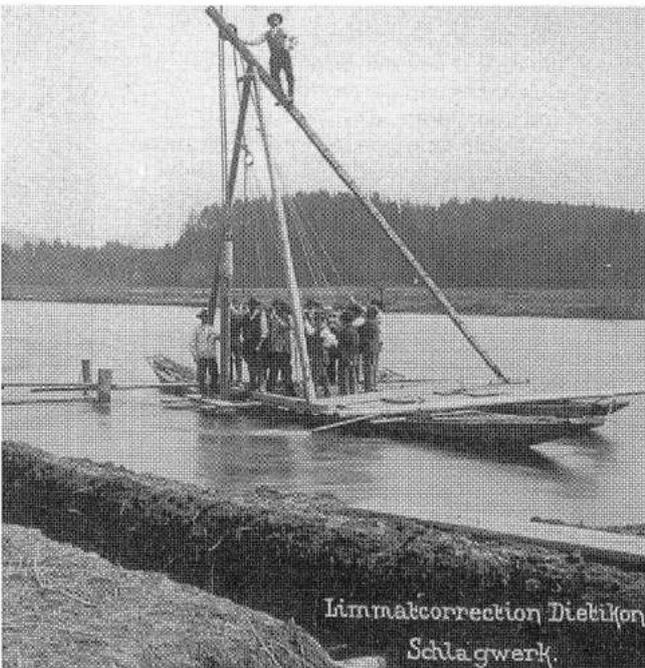
Das schwimmende Schlagwerk zum Einschlagen von Pfählen ist die handbetriebene Ausführung einer heutigen Ramme.
