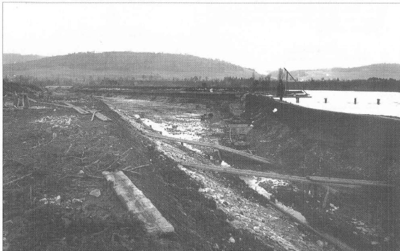
*Nur die vollständige Schliessung des Klappenwehrs machte den Ausbau und die Neugestaltung des Fabrikkanals zu den Webereien und dem späteren Elektrizitätswerk möglich. Erstaunlich, dass die weitgehend abgetragene rechtsseitige Kanalmauer entlang der Limmat den Wassermassen des Flusses ohne Spundwände standzuhalten vermochte.*
