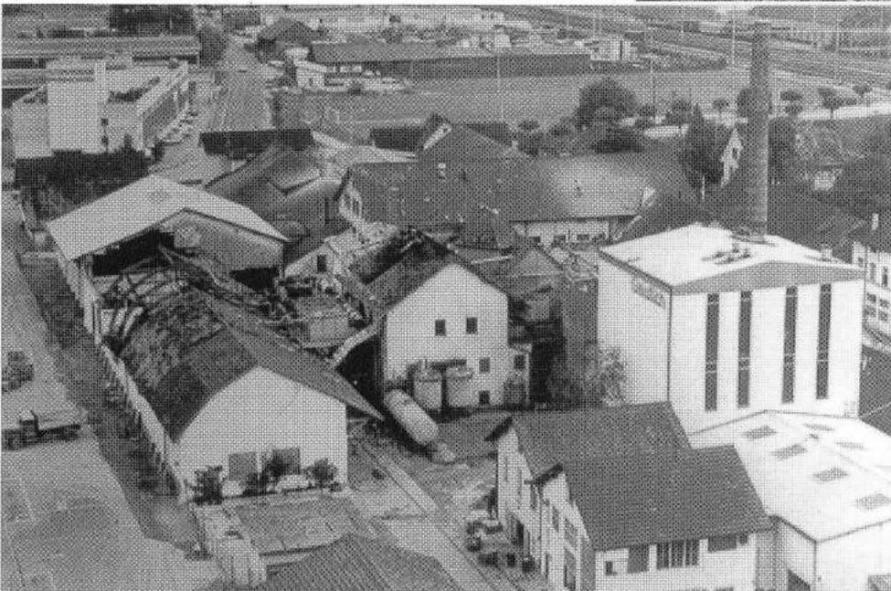
*Die Explosion eines Extraktionskessels hat die gesamte Knochen-Extraktionsanlage zerstört.*
