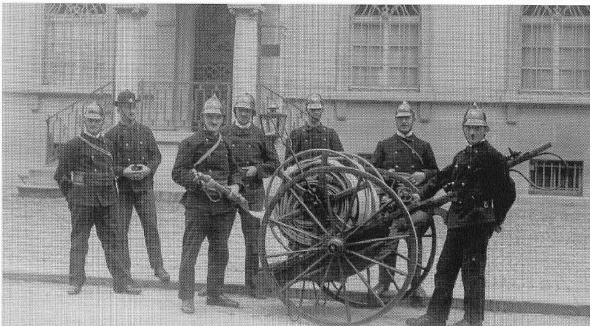
Der Hydrantenzug mit einem Hydranten- oder Schlauchwagen (um 1925) noch ohne Gummibereifung und Anhängervorrichtung vor dem einstigen Gebäude der ZKB, Zürcherstrasse 20.
