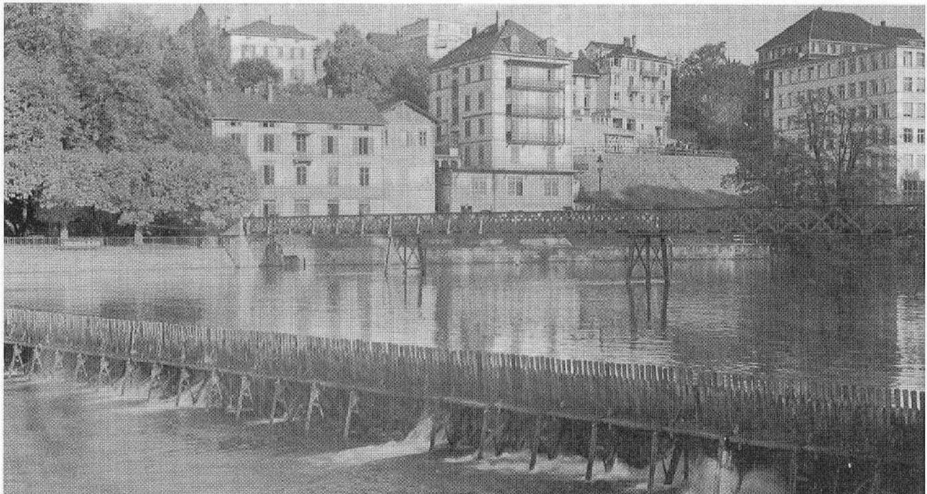
Das alte, hölzerne Nadelwehr (um 1875) am Platzspitz diente nicht der Regulierung des Seespiegels, sondern lenkte nur einen Teil des Limmatwassers in den Wasserwerkkanal zum Elektrizitätswerk «Letten». Letzteres ist noch immer in Betrieb und wurde kürzlich modernisiert.
